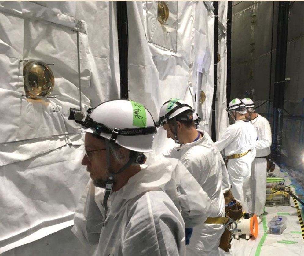
Установка модулей ФЭУ+WLS в OD Super-Kamiokande. Картина в Нурег-К будет примерно такая же.
