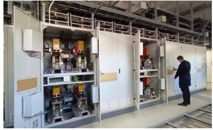
Системы шинопроводов смонтированы и готовы к работе
