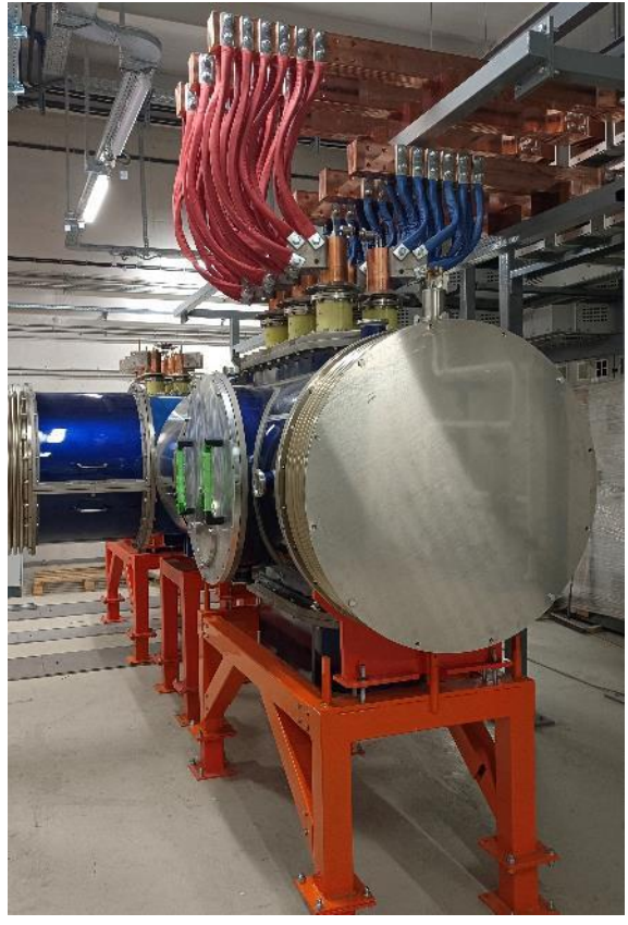
Системы шинопроводов смонтированы и готовы к работе
