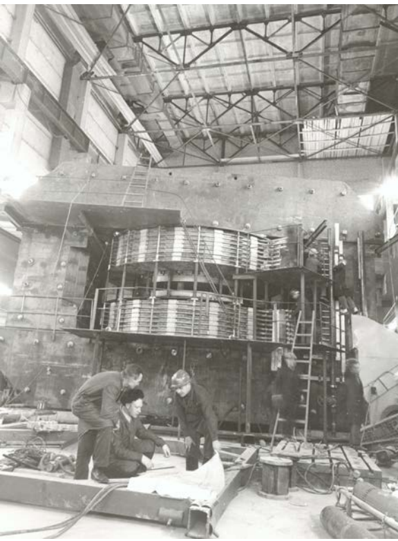
Монтаж ускорителя У-400
