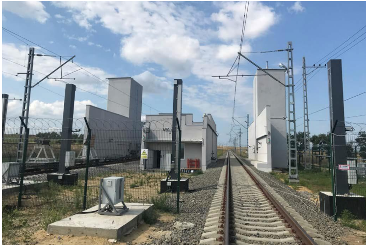
Двухпутевой ж-д ИДК
